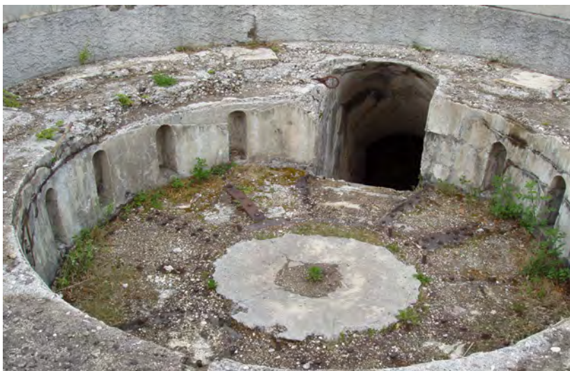
Forte Osoppo – interno torre da 149 già blindata
